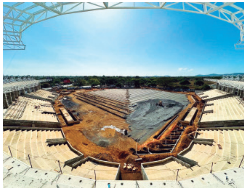
Vista panorámica del área de graderías y área del campo de juego.
