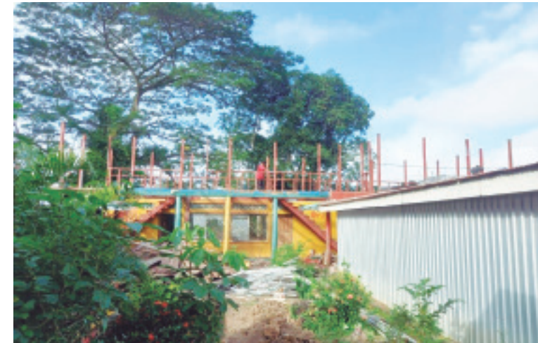
Se observan los avances de los trabajos de preliminares, específicamente de desinstalación de estructura y cubierta de techo, cielo raso en el segundo nivel.
