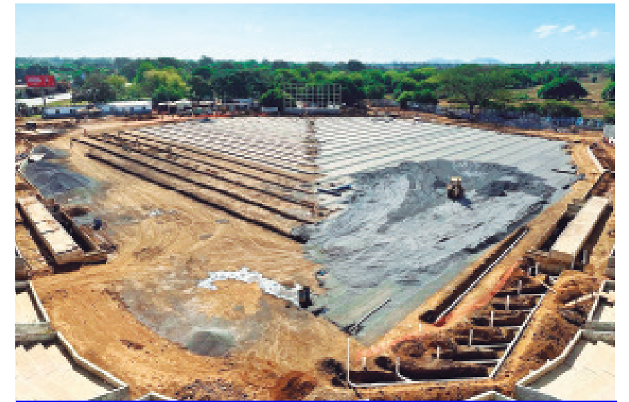
Se aprecia el área de juego, específicamente la construcción del sistema de drenaje pluvial tipo espina de pescado y los avances en la instalación de la geotextil y tubería perforada para drenaje pluvial del campo de juego.
